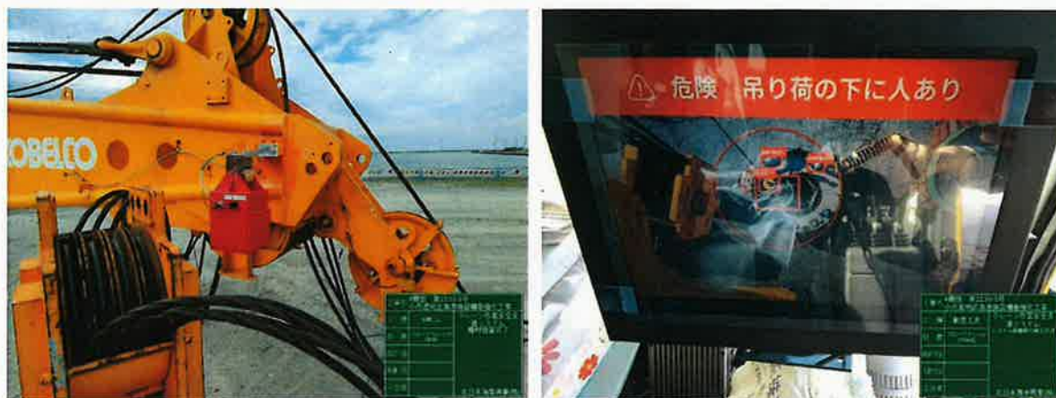
クレーン作業安全支援システム(NETIS 登録)による吊荷内の作業員等監視状況
